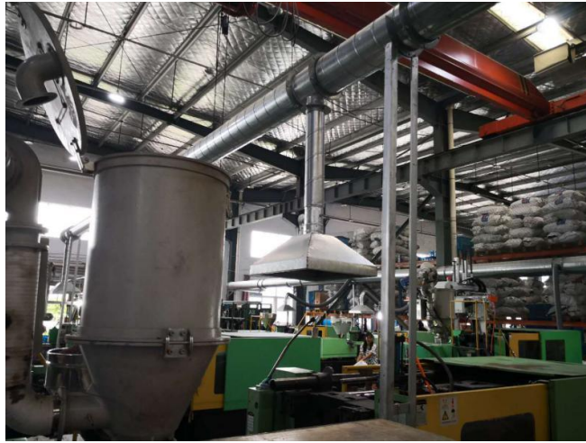
兰溪墩头废气处理环保装置
